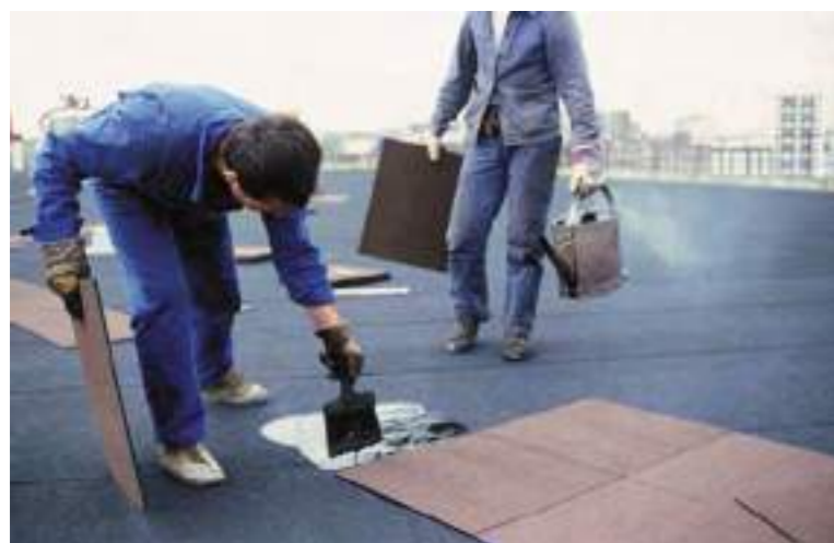
Рис. 12 Укладка плиток Dalle Parcours
