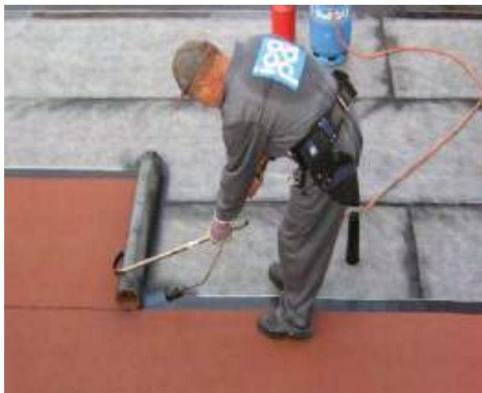
Рис. 13 Укладка верхнего слоя материала наплавлением
