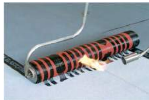
Рис. 14 Укладка материала СИНТАН
